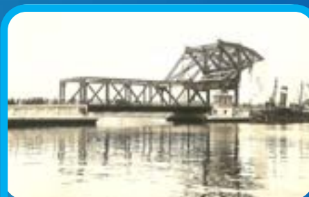
Construction du pont du chenal maritime.
