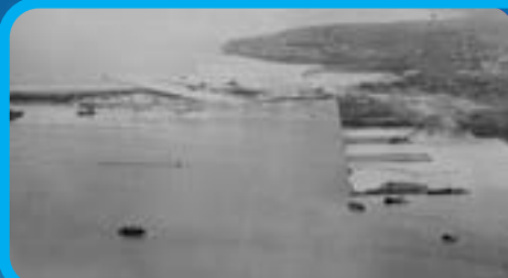
Construction des quais qui s'étendent dans la baie de Toronto, du quai Bathurst jusqu'à la rive ouest de la rue Bay, et des zones situées entre la rue Bay et la rue Yonge.
